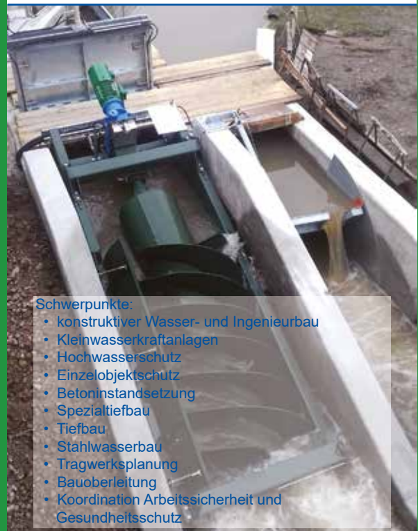
Foto: Gerhard Sparborth - Wasserkraftschnecke Fockendorf
